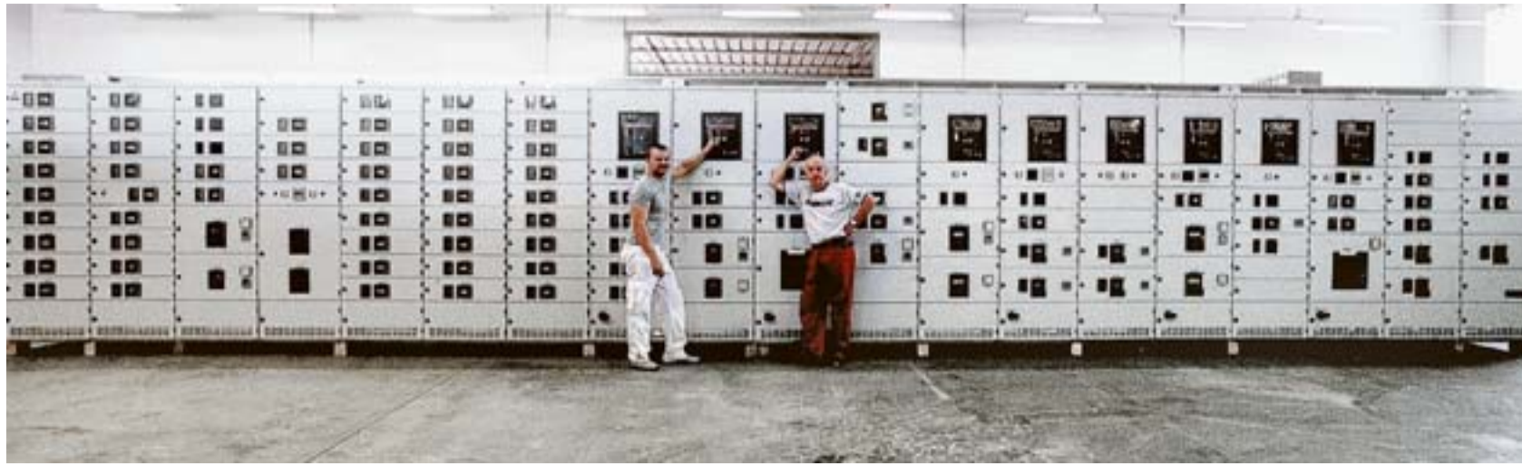
Jimi Pellattiero e Giuliano Bertoldo, titolari della Cabel System, posano orgogliosi davanti al quadro di bassa tensione destinato allo stadio Meazza di Milano.
